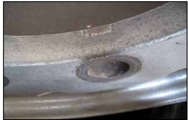
Corrosión galvánica en la zona de las tuercas de la llanta y en el interior del orificio central
