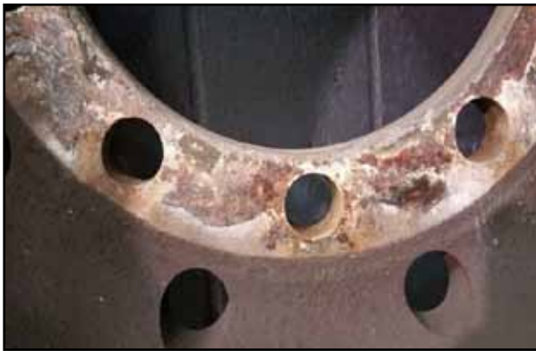
Corrosión galvánica en las superficies de contacto de la llanta
